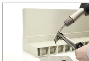
CORRECTA INSTALACIÓN SOLDADURA-CABEZAL
